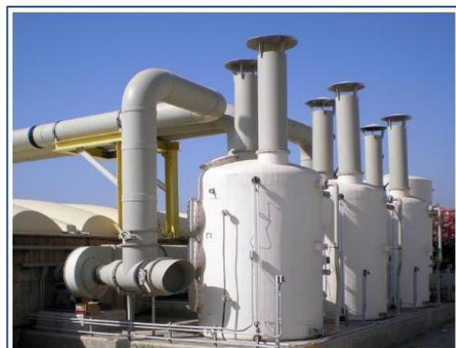
El ventilador está calculado para vencer las pérdidas de carga de los conductos de aire y del propio filtro de carbón. El equipo propuesto estará diseñado para la extracción de 18.000 Nm<sup>3</sup>/h.
