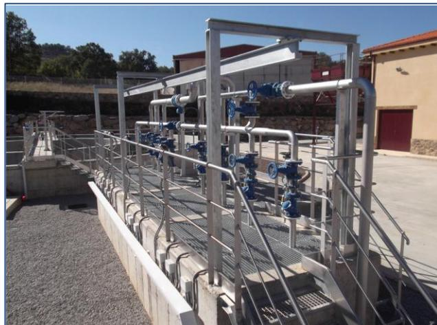
Los fangos a recircular, purgados del clarificador, son conducidos por gravedad hasta una arqueta donde se inicia la elevación de los fangos de retorno que se realiza con bombas sumergibles que no rompen el floculo.
