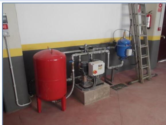
La instalación se completará con un filtro automático, construido en acero al carbono con malla en acero inoxidable, conexión por bridas, caudal de 12-40 m<sup>3</sup>/h. Presión máxima de trabajo 10 bar. Paso de filtración 130 micras. Actuación hidráulica, con programador de lavado por tiempo/presión diferencial.
