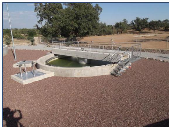
La decantación separa por la simple acción de la gravedad el agua de los fangos. Es pues, un medio mecánico sencillo, cuyo funcionamiento precisa un aporte mínimo de energía. En el caso que nos ocupa, la eliminación de la materia sedimentable presente en el agua, se realiza mediante un decantador de 10 metros de diámetro
