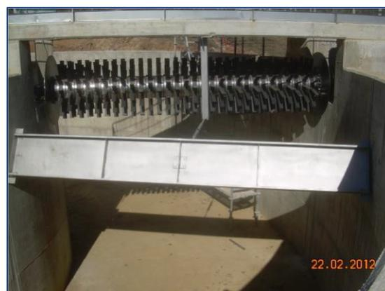
La cuba de aireación recibe el efluente del pretratamiento y los fangos de recirculación del clarificador secundario. Este a su vez, recibe el agua de la cuba de aireación y los fangos extraídos en él, se distribuyen a la cuba (Recirculación de fangos) o a las instalaciones de fangos biológicos (fangos en exceso).
