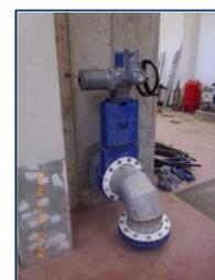
Para efectuar la regulación de un modo fiable, se dispone a la salida del primer cuerpo de la citada arqueta, de una tubería con un diámetro DN-250 dirigida hacia el tratamiento biológico donde se instalará un medidor electromagnético y una válvula de guillotina motorizada de DN-200, con señal 4-20 mA. Dicha válvula, será comandada por la señal registrada en el medidor electromagnético que va al biológico.
