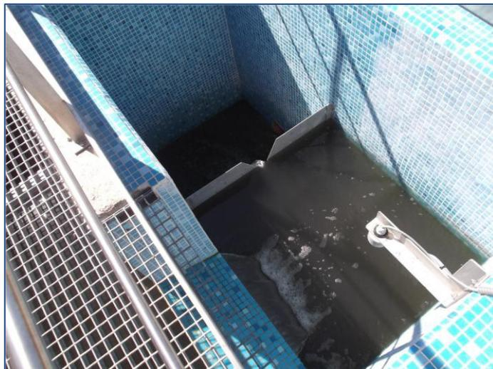
Con estos datos se diseña una cámara con una longitud de 2 metros, una anchura de 2 metros y con un calado de 2,25 metros, resultando un volumen útil de 9 m<sup>3</sup>.
